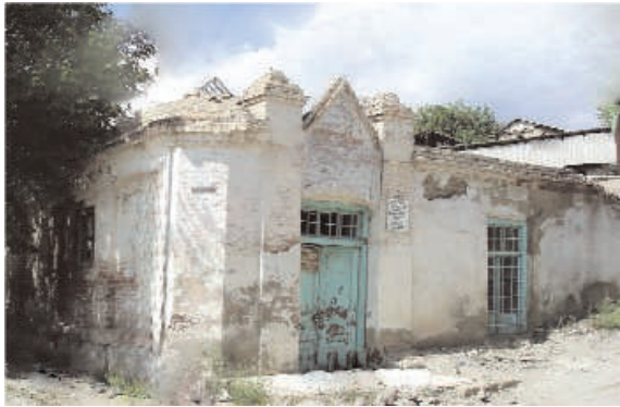
Şəkil 1. Ordubad şəhər hamamı
